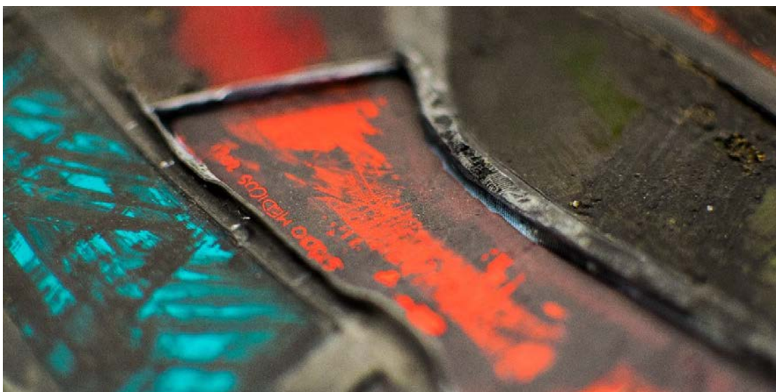
wll c3 Eingesetztes Duplikat mit noch aufgebogenen Bleiruten und dem Vermerk „Studio Medicus 2021“
