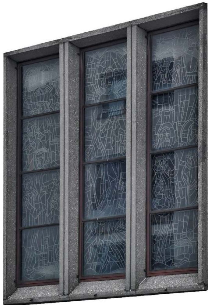
wll Staubablagerungen bei Segmenten a4, c1 und c4 gut sichtbar
