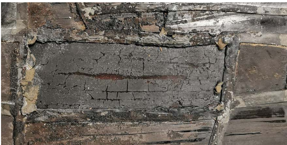
wII c3 Unsachgemäß restauriertes Glasstück, vmtl. mit schwarzem Lack. Dieser Mangel trat insg. nur sporadisch auf.
